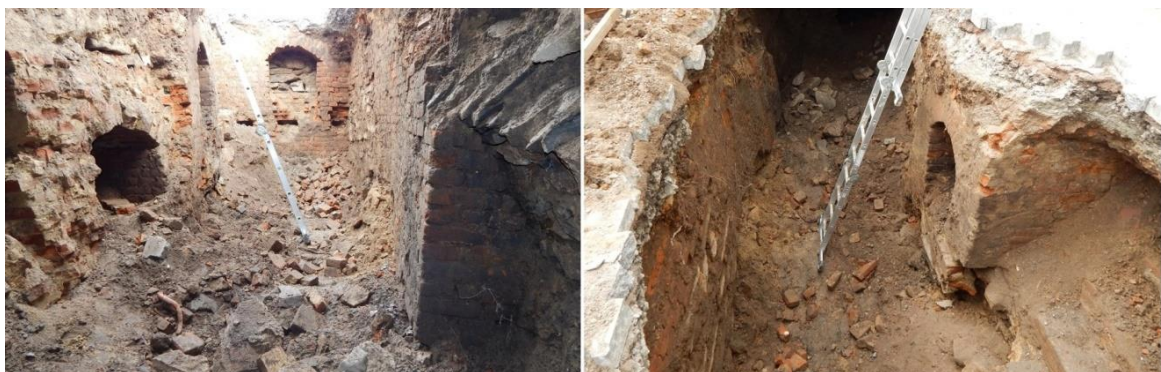
Рис.9. Приміщення № 3 у вигляді коридору у східній частині Звягельського підземелля
